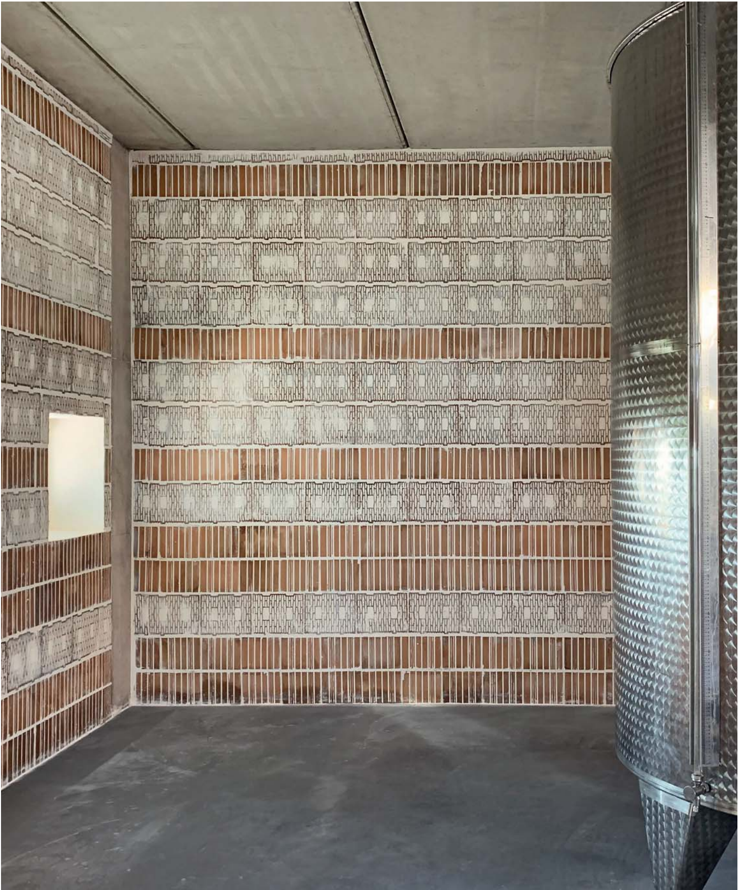
Pareti di tamponamento con fasce orizzontali in mattoni alternati a blocchi in laterizio posati con foratura a vista. © Edoardo Milesi
