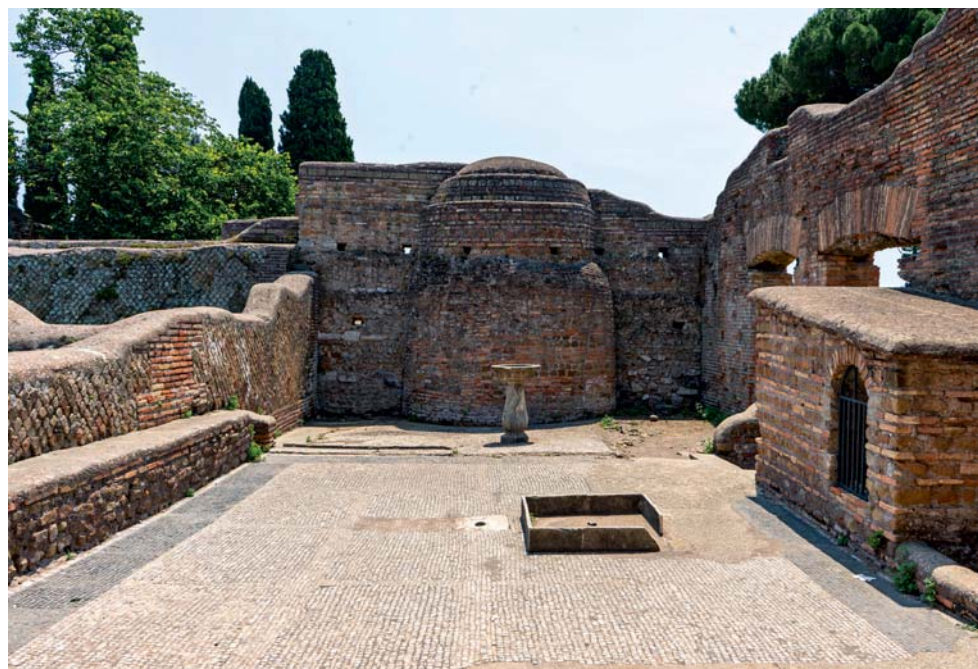
4. Vista del cortile interno, con la panca per i clienti, le fontane, la struttura di copertura delle scale e, sul fondo, l'abside seriore dell'Aula del Buon Pastore.
