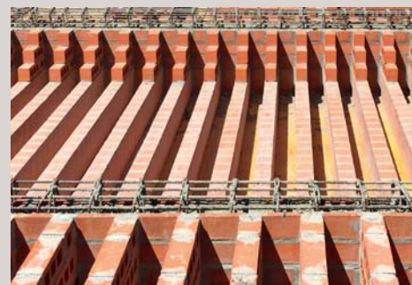
Costruzione del solaio di copertura.
