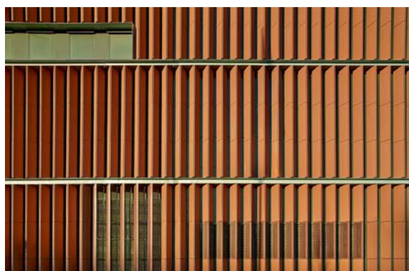
9. Centrale Värtan Bioenergy CHP-plant KVV8, 2013-2016, Stoccolma, Svezia. © Robin Hayes
