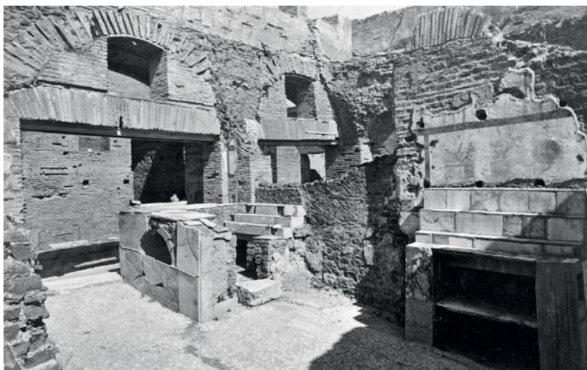
5. Vista dell'interno negli anni Trenta, prima del rifacimento delle volte a crociera, in cui si possono osservare i presidi strutturali realizzati per archi e piattabande (ICCD G001522).
