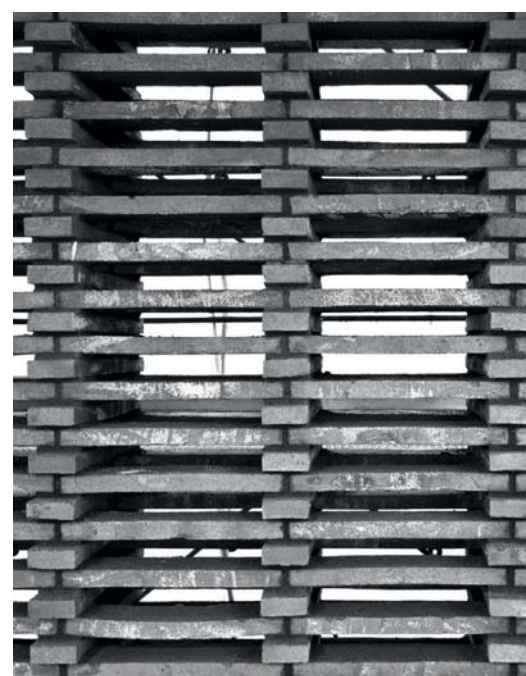
La parete di gelosie in laterizio in costruzione. © Stocker Lee
