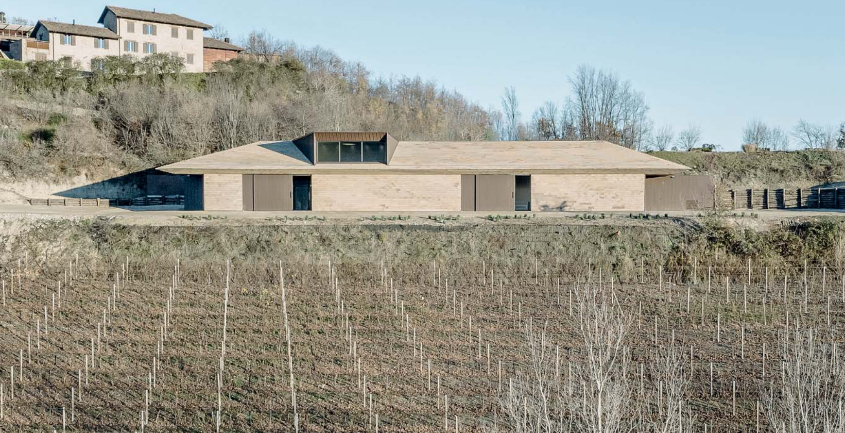
Vista generale della cantina immersa tra i vigneti.
