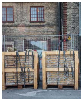
11. Fasi del processo realizzativo dei pannelli: taglio, applicazione della cornice, trasporto e installazione. © Lendager Group
