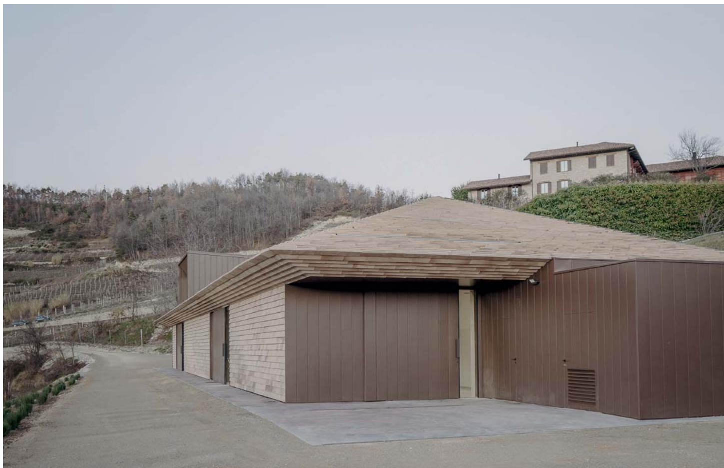
Vista del fronte sud-ovest: in primo piano la copertura in pannelle di laterizio.
