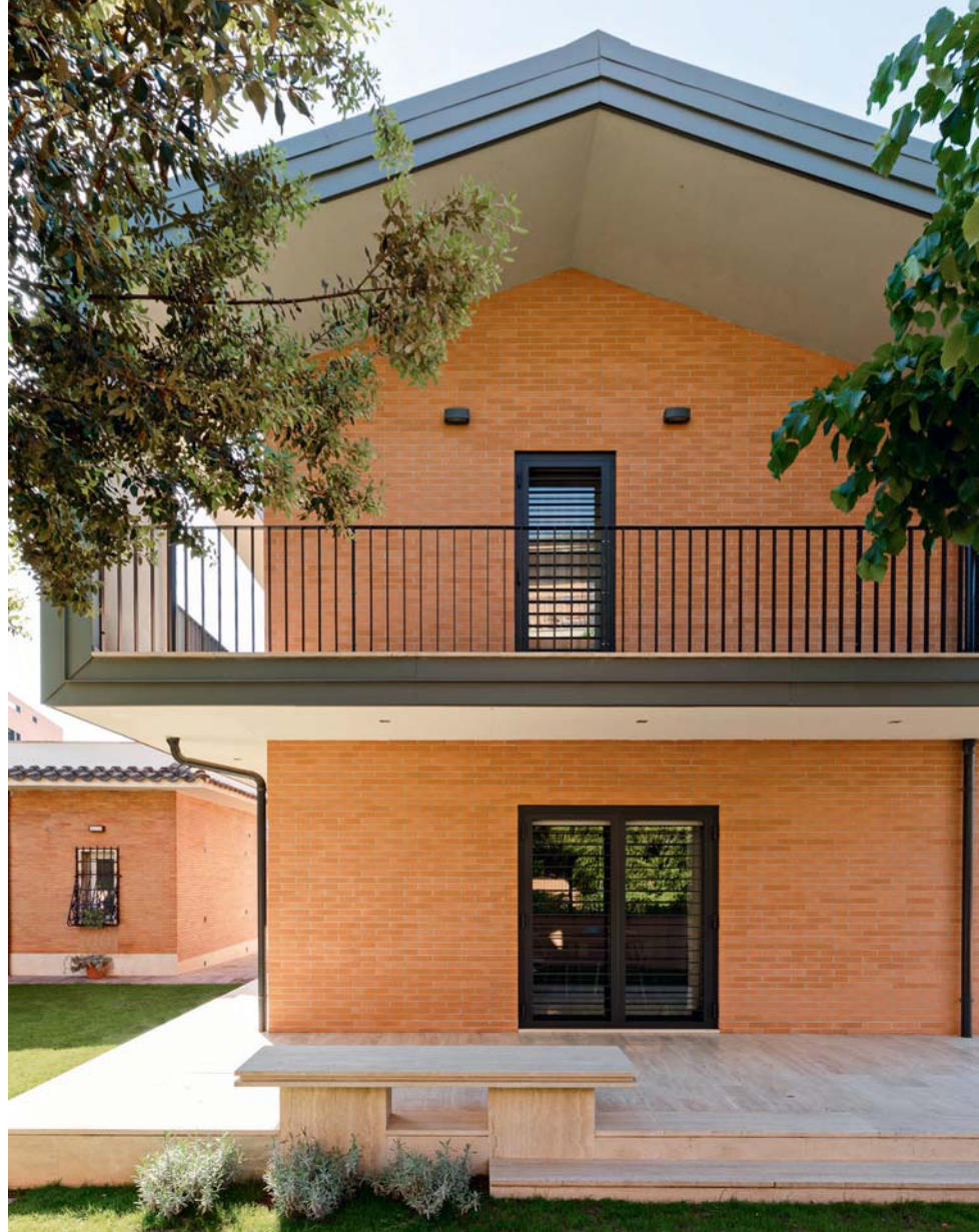
Vista del prospetto orientato a est dal giardino.
